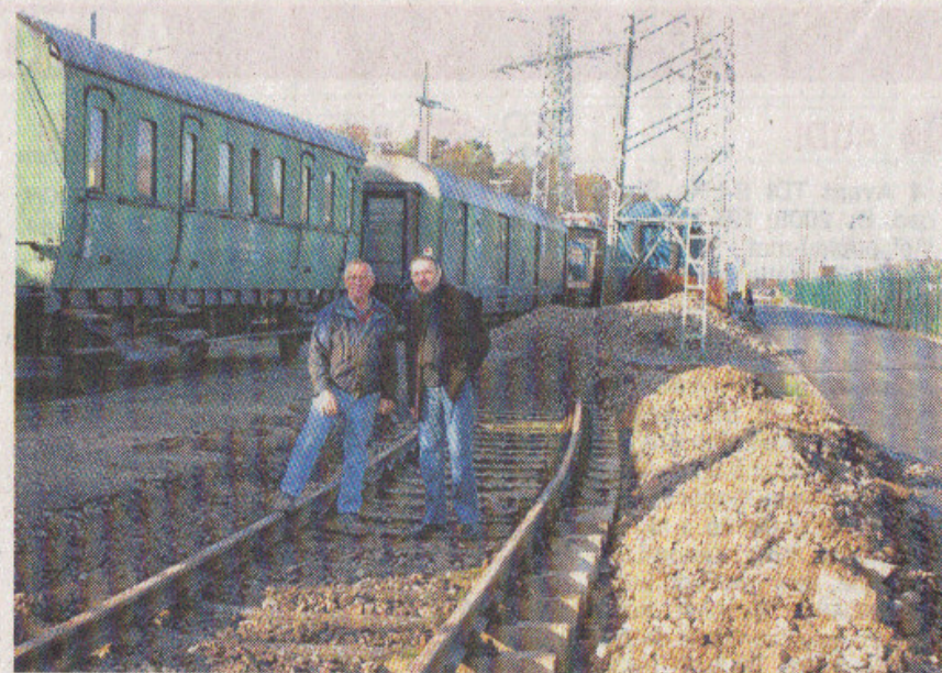
Gernot Dackermann (links) und Hans-Peter Alter zwischen Eisenbahnwaggon und Schotter: Noch müssen die Gleise fertig verlegt werden, doch bis zum Jahresende sollen die Arbeiten abgeschlossen sein.
